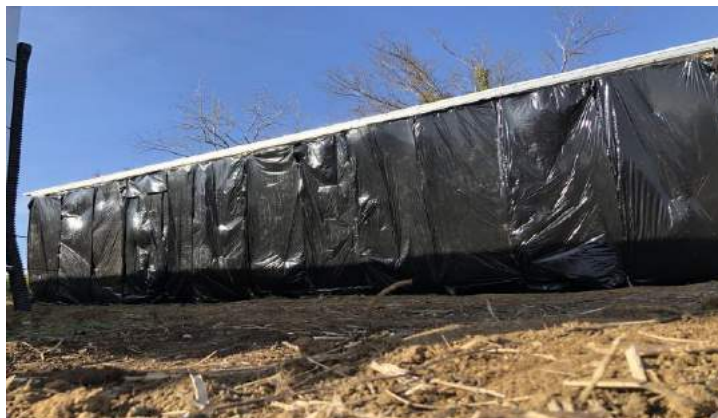
図5.2.3.3マルチシートを遮光スクリーンに
