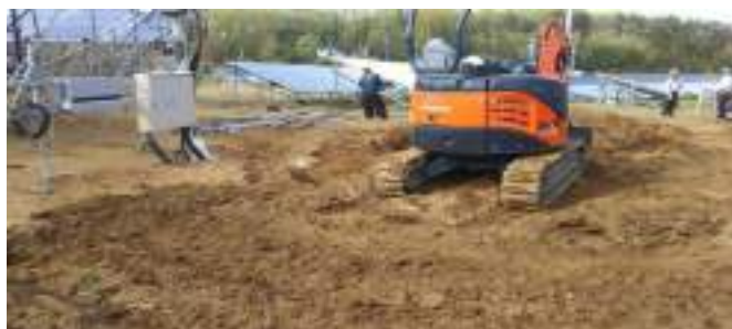
図 3.11.1 本庄作業整地
