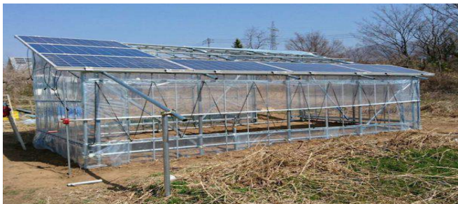
図 3.5.1 育苗施設北杜市大泉谷戸
