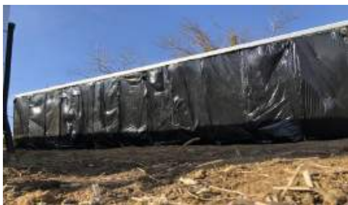
図5.2.3.3マルチシートを遮光スクリーンに
