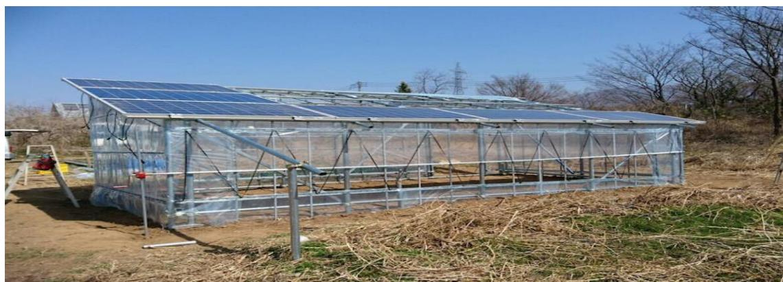
図7 ソーラーパネルを載せたビニールハウス
